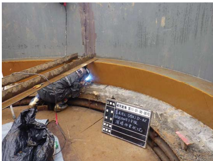
3, 鋼製刃口 溶接接続
