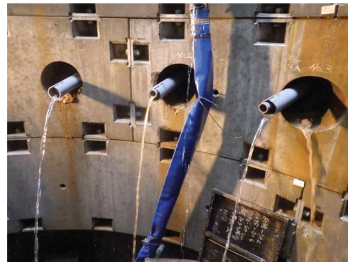
5, 集水管及び鞘管の設置状況
