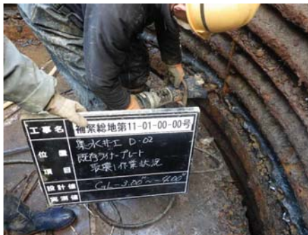
油圧カッターによる切断
