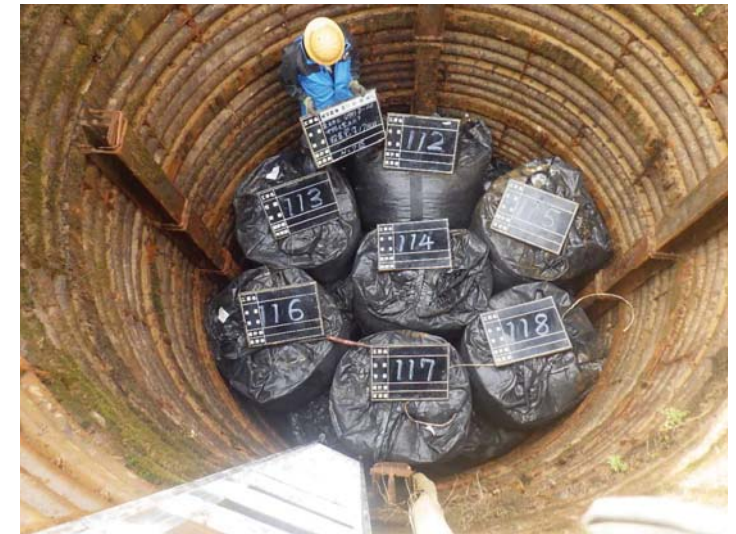
• 大型土嚢 設置状況（下部）
