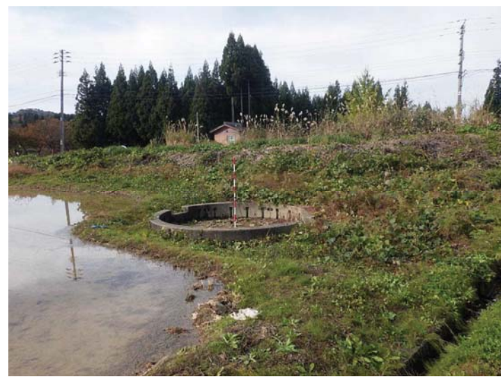
1, 施工前 ・ 既設ライナープレート(φ3500) ・ 上部にCo(φ4000)が嵩上げ ・ 天蓋はエキスパンドメタル
