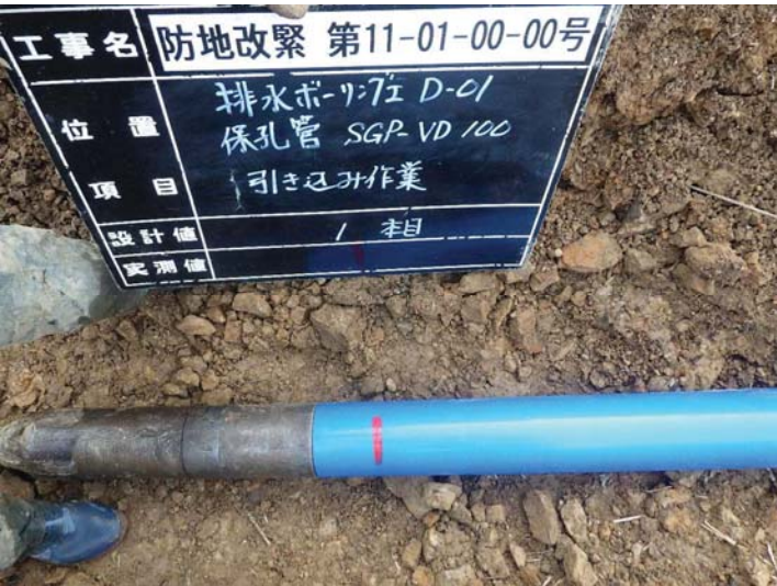
3, 排水管(SGP)の引き込み設置
