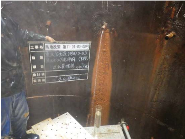
1, 洗浄前 湧水量測定
