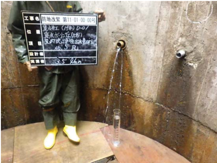
4, 洗浄後 湧水量測定
