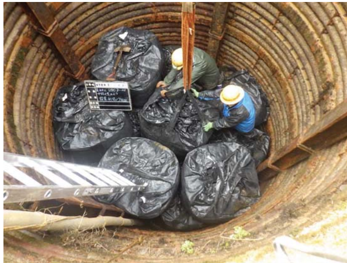
• 大型土嚢 設置状況（下部）
