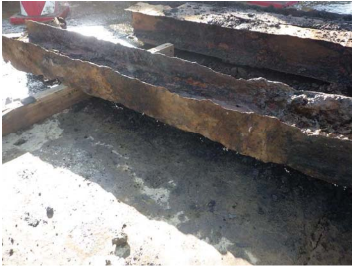
2, バーチカルスティフナー(1) ・ 腐食により柱の形状がいびつ
