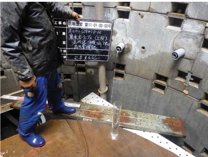
4, 洗浄後 湧水量測定
