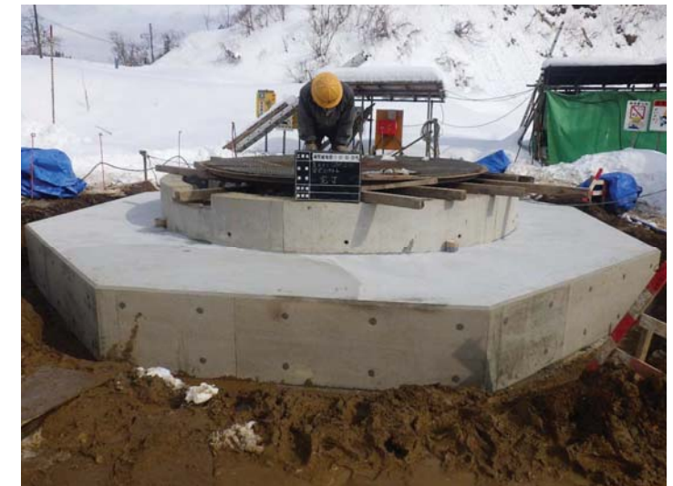
4, 固定コンクリート盤の設置完了
