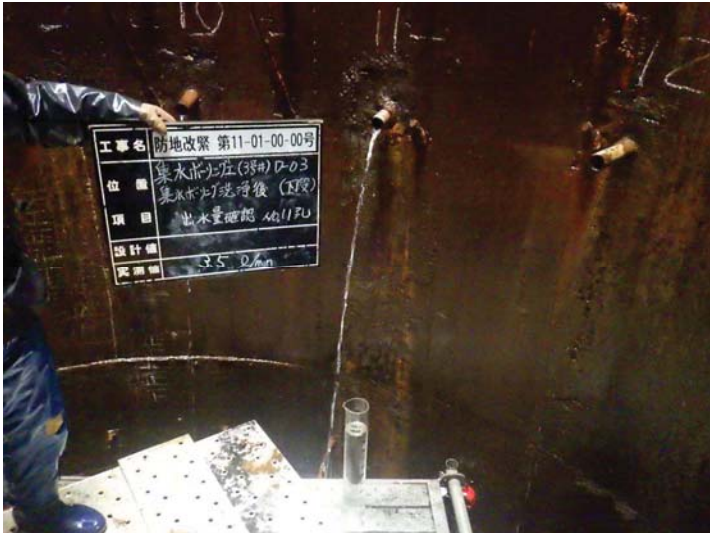
4, 洗浄後 湧水量測定
