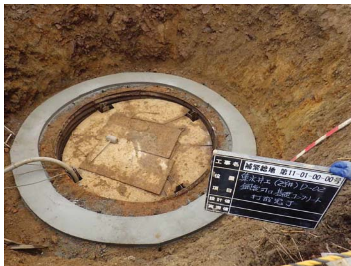
1, 鋼製刃口 基礎Co設置
