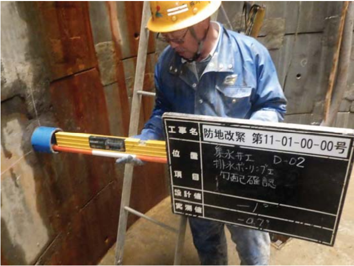
4, 排水管(飲口 D02)設置勾配 -0.7度
