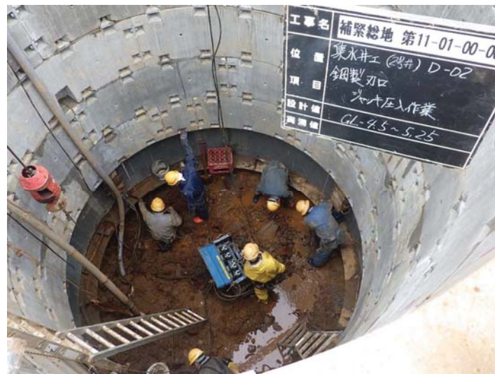
1, 鋼製刃口の圧入状況 (電動1)
