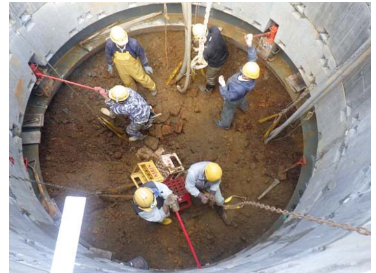
2, 鋼製刃口の圧入状況 (手動)
