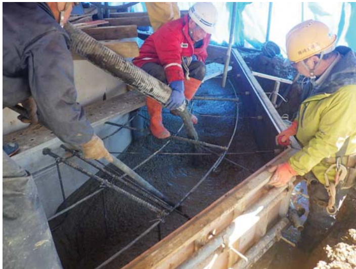
3, コンクリート打設状況
