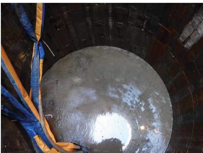
5, 底張りコンクリートの打設完了
