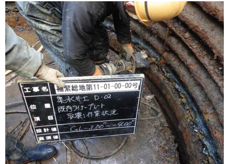
2, 油圧カッターによる切断
