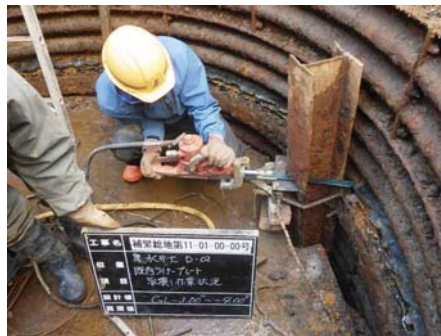
レシプロソーによる切断
