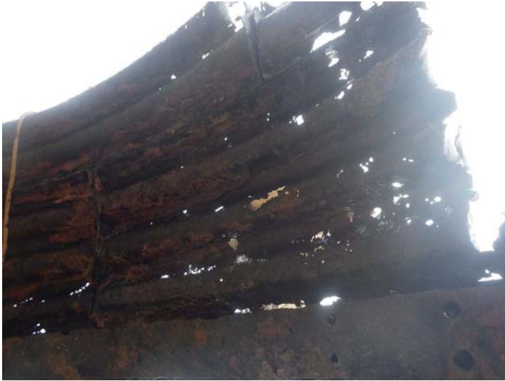
1, ライナープレート ・ 腐食により鋼材に無数の穴が開いている
