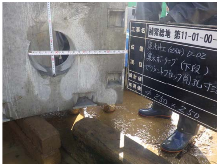
3, ブロックの開口径 \phi 250\text{mm}
