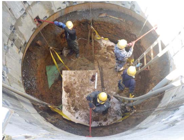
1, 手動による鋼製刃口の切離し
