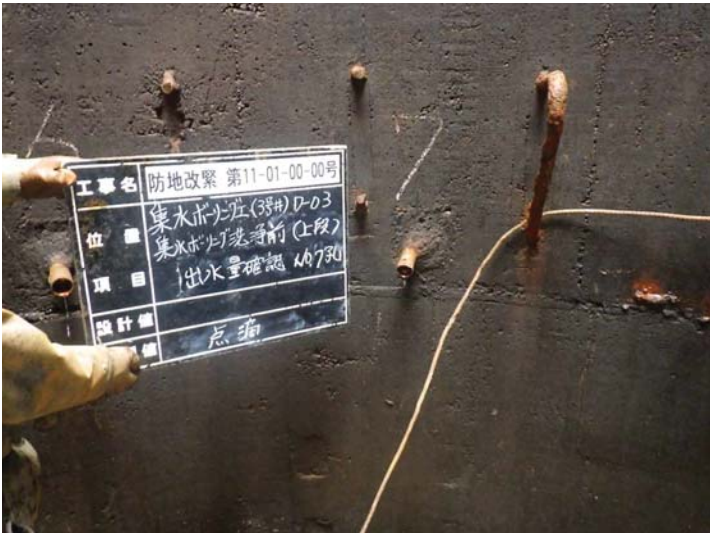
1, 洗浄前 湧水量測定
