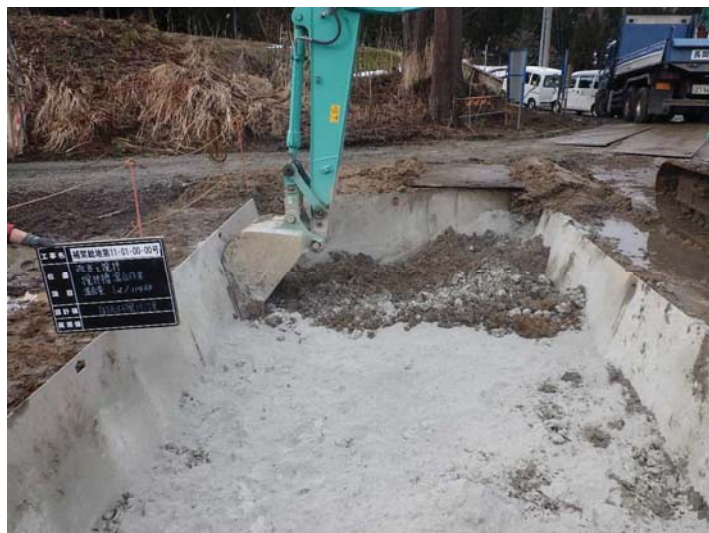
1, セメント固化材のバックホウ混合
