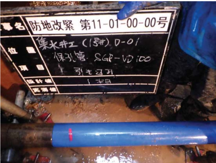
3, 排水管(SGP)の引き込み設置
