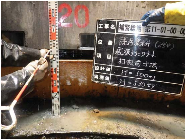
2, 底張りコンクリート 深度検尺
