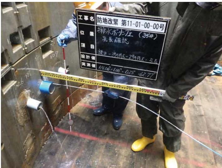
5, 排水管(吐口 D02)設置状況
