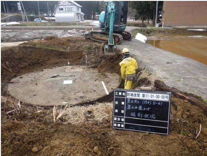
2, 井筒周辺地盤掘削状況
