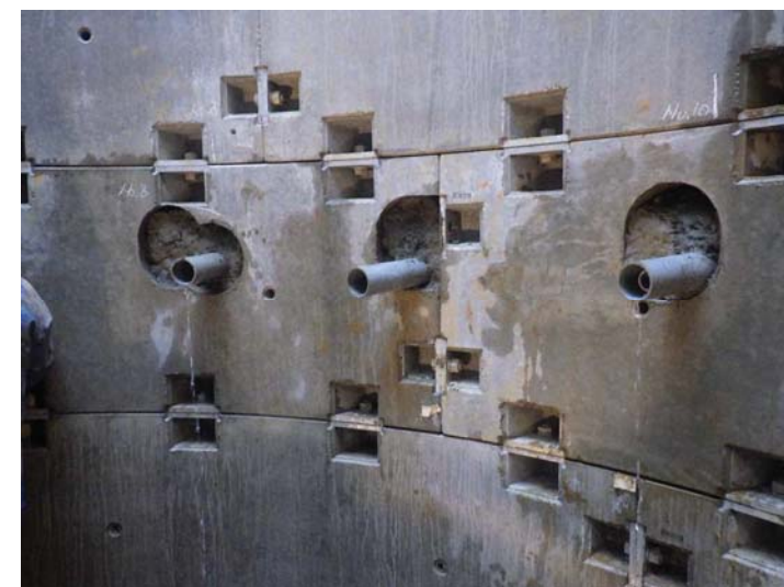
5, 集水管及び鞘管の設置状況
