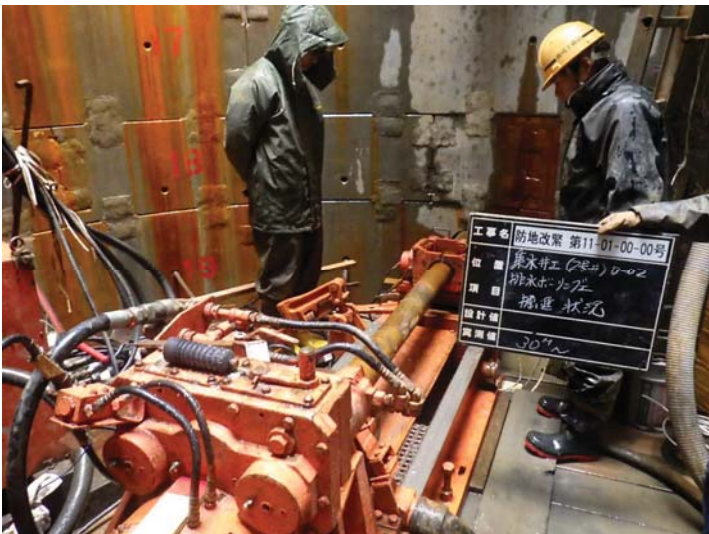
1, 排水Bor工 (掘進施工中)
