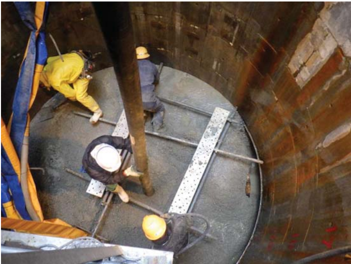
4, 底張りコンクリートの打設状況
