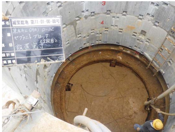
3, セグメントブロック5段目設置完了
