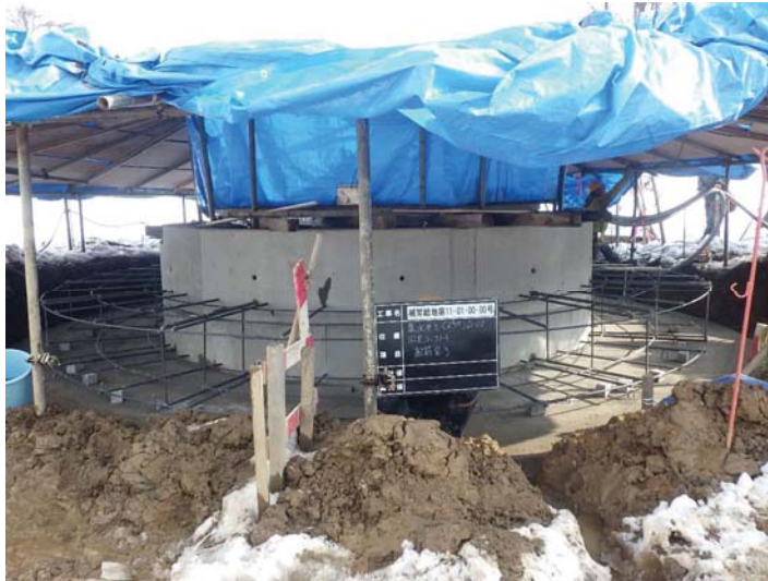
1, 固定コンクリート盤の配筋
