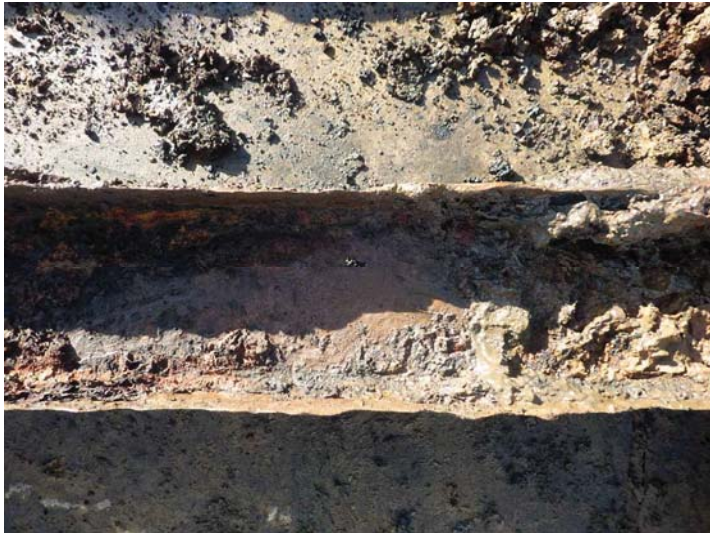
3, バーチカルスティフナー(2) ・ 腐食により鋼材の肉厚が薄い
