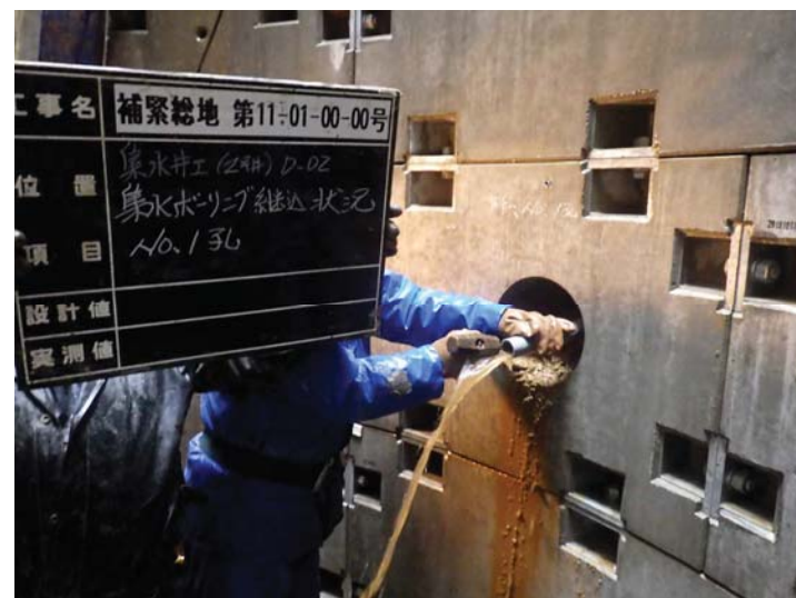
3, 集水管の継込み
