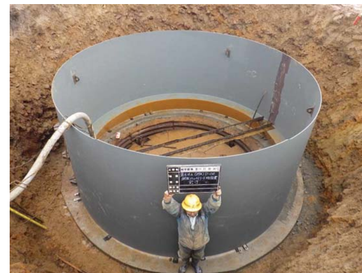
5, 鋼製刃口 設置完了
