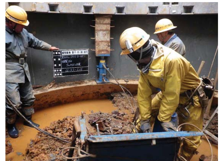
2, 鋼製刃口の圧入状況 (電動2)
