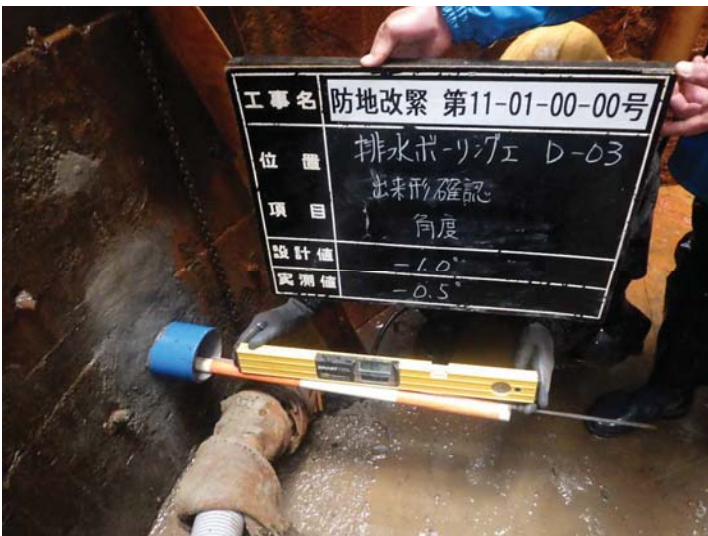
4, 排水管(飲口 D03)設置勾配 -0.5度
