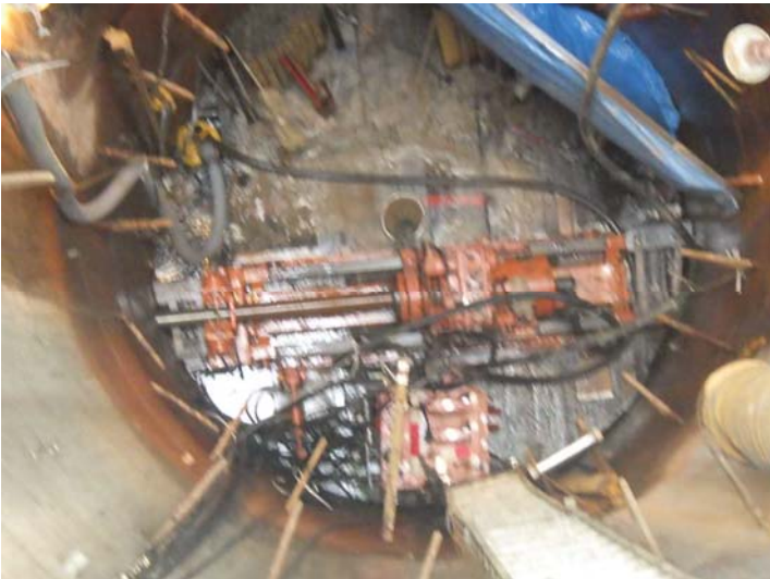
1, 排水Bor工 (掘進施工中)
