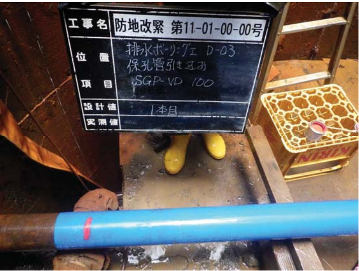
3, 排水管(SGP)の引き込み設置
