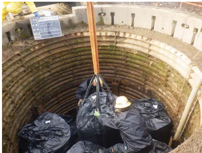
• 大型土嚢 設置状況（上部）
