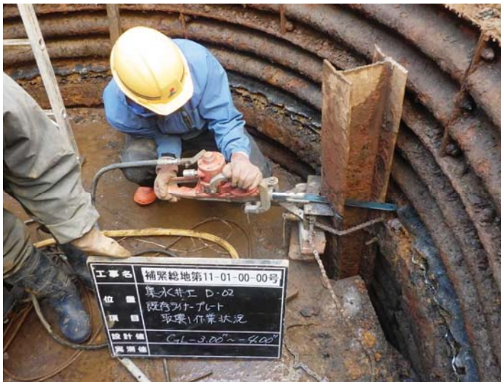
3, レシプロソーによる切断
