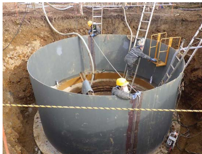
4, 溶接後の変形有無の確認
