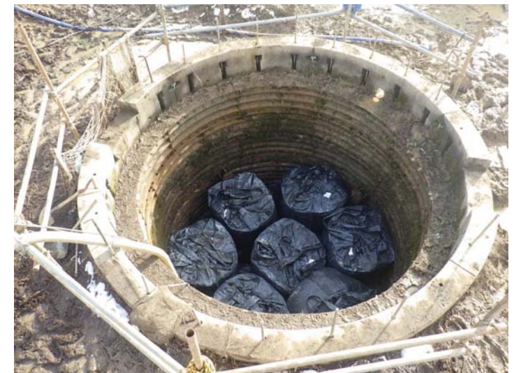
• 大型土嚢 設置状況（上部）
