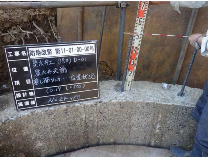
3, 既設井筒 差し筋設置
