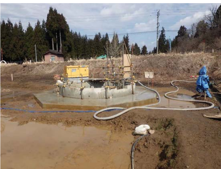
2, 施工中 ・ 固定コンクリートを打設し、セグメントブロックにより施工
