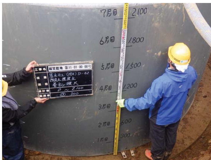
3, 改良土埋戻し 巻出し検尺
