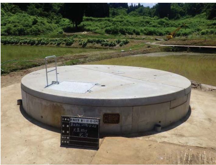
3, 施工後 ・ カメラ点検孔付きCo製蓋
