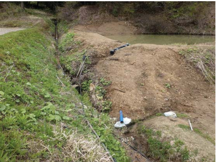
5, 排水管(吐口 流末)設置状況
